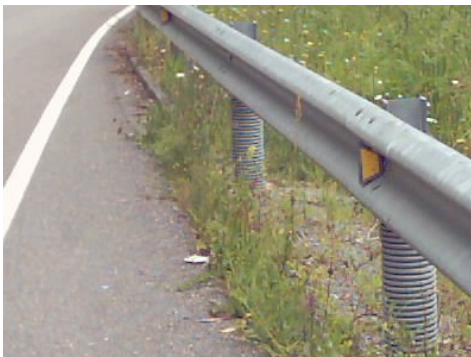
Figura 7: Proteção dos postes de um guardrail[10]
