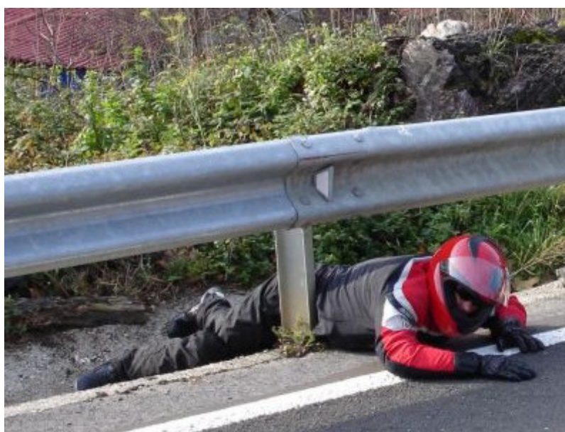
Figura 4: Exposição do corpo do motociclista ao poste do guardrail, mesmo com os equipamentos de segurança[10]
